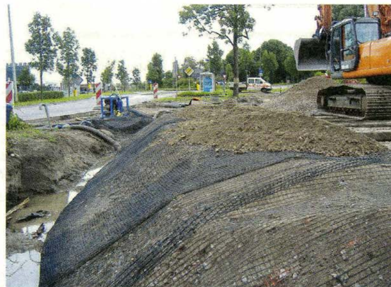
Paalmatras in de Zuiderlingedijk. Foto's: D. van Biezen Heipalen BV
