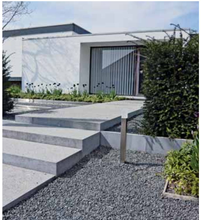
4 Bij een trap met een beperkt aantal treden kan voor verticaal geplaatste blokken worden gekozen. In dit geval moet voor de voegen waterdichte mortel worden gebruikt.
