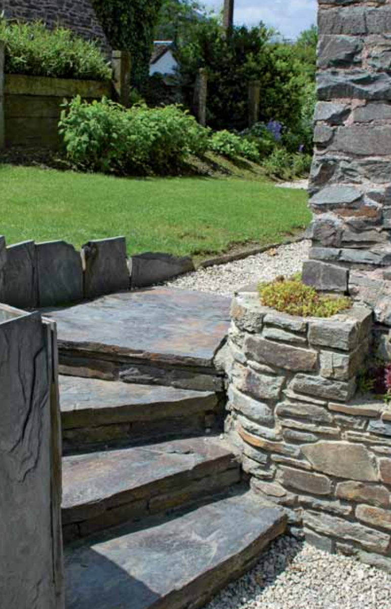
1 De trapboom van deze trap bestaat uit grote, verticaal geplaatste schisttegels: de onregelmatigheid van de stenen maakt hem heel origineel. PRIVÉTUIN, MOGIMONT, ONTWERP HUGHES FERNET/LE BOUILLON BLANC
