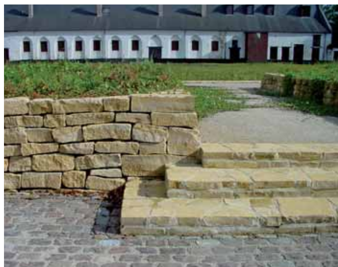
2 Voor de eigentijdse evocatie van de abdijtuinen is zanderige kalksteen van Fontenoille gebruikt. Deze heel bleke steensoort is hier gekozen voor de lage muurtjes, de brede boorden en de gemetselde trappen die dit deel van de tuin vorm geven. ABDIJ VAN ROODKLOOSTER, OUDERGEM, ONTWERP JNC INTERNATIONAL
