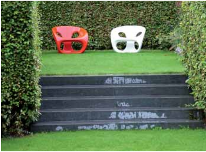
1 Blokken in blauwe hardsteen met een lengte van een meter vormen een goed uitgedachte overgang tussen twee tuinniveaus. PRIVÉTUIN, TIELT, ONTWERP CHRIS GHYSELEN
