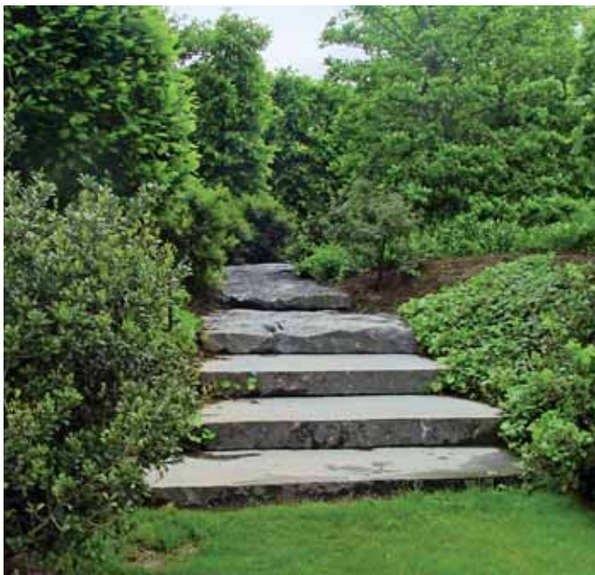
3 Het onderste deel van de trap bestaat uit gezaagde blauwe hardsteen-tegels. Halverwege is dan voor korstplaat van blauwe hardsteen gekozen om de overgang naar een volgend, wilder tuingedeelte extra in de verf te zetten. PRIVÉTUIN, HAUT-ITTRE, ONTWERP JEAN DELOGNE
