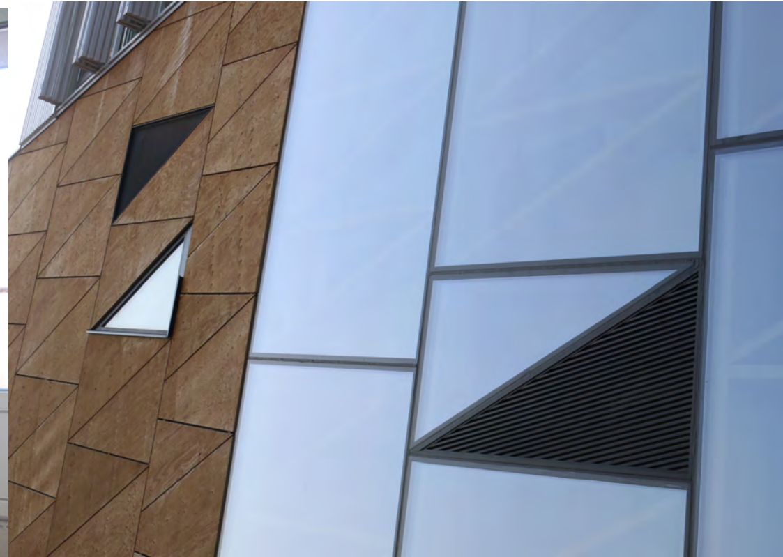
Nachtventilatioerooster in Greenbizz Brussel, bron: Azimut Bouwbureau
