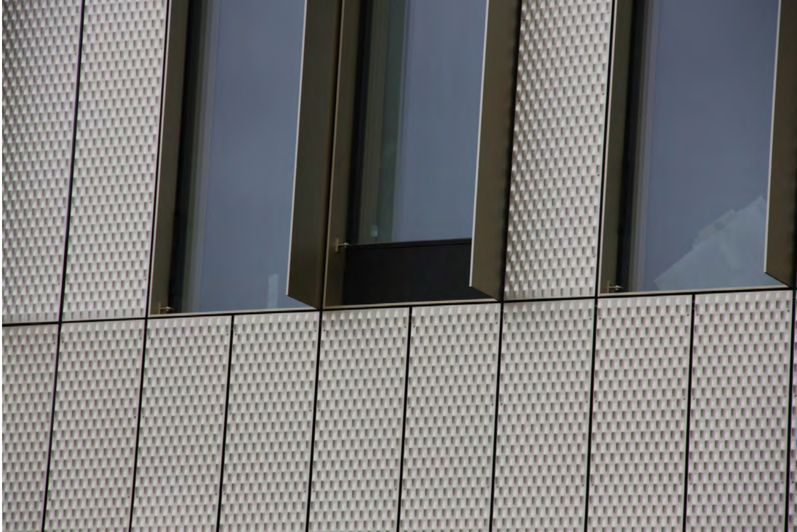
Zomernachtventilatieluik kantoorgebouw Elia Brussel, bron: Azimut Bouwbureau
