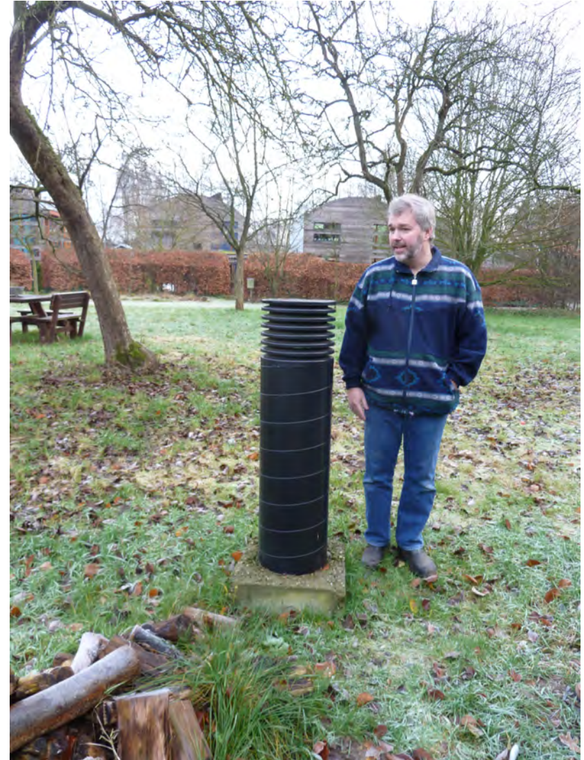
Luchttoevoer via grondbuis in de Nulwoning te Groenlo, bron: Azimut Bouwbureau
