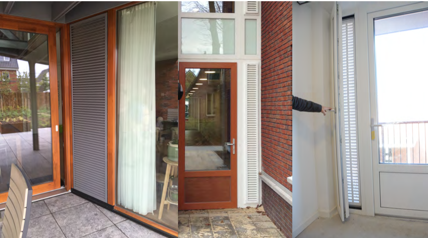
Inbraakwerende ventilatieluiken, bron: BouwNext
