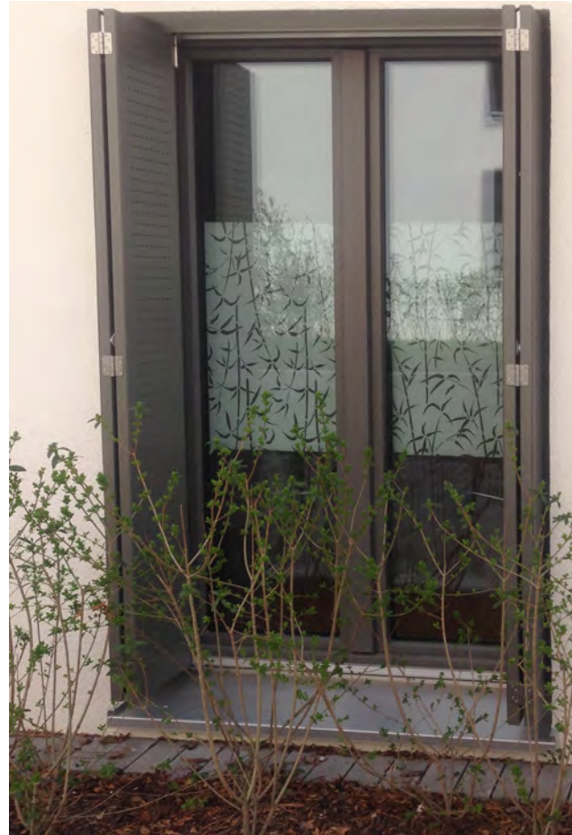
Buitenzonwering, bron: Azimut Bouwbureau
