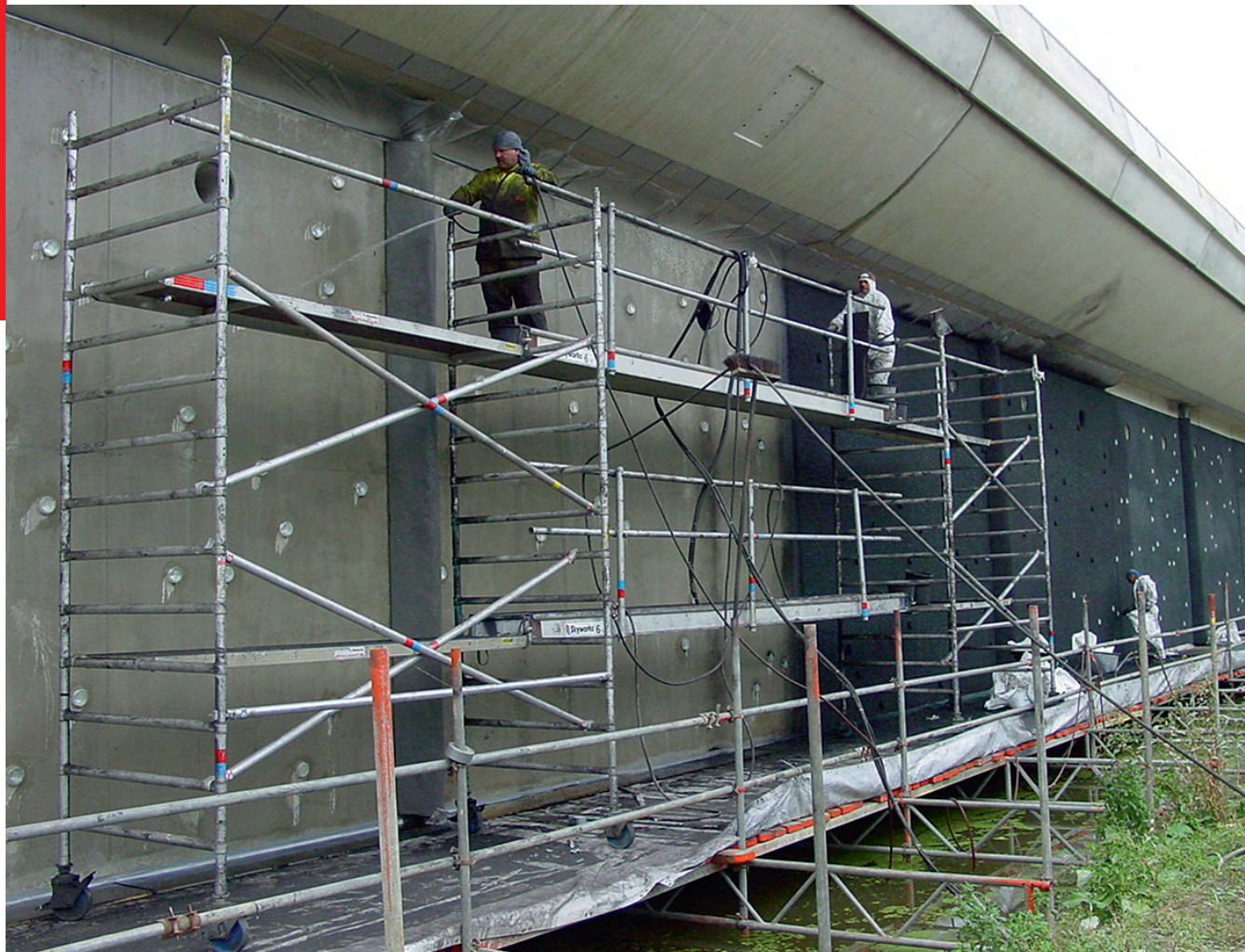
▲ Het aanbrengen van een lijmlaag op de wanden van de havenspoorlijn
