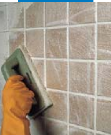
Gebruik van Scotch-Brite® bij het afwerken van enkelgebakken tegels
