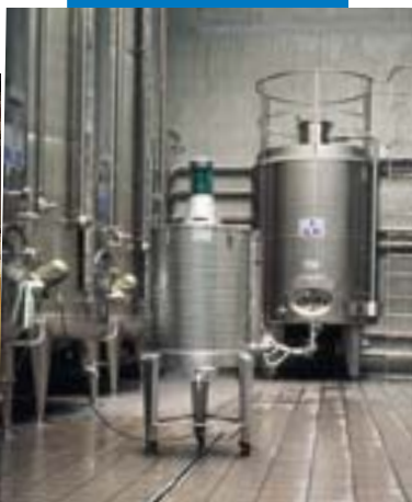
Voegwerk in een wijnkelder
