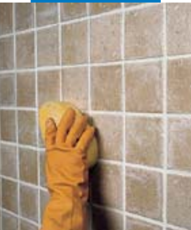
Gebruik van een spons bij het afwerken van een wand van enkelgebakken tegels
