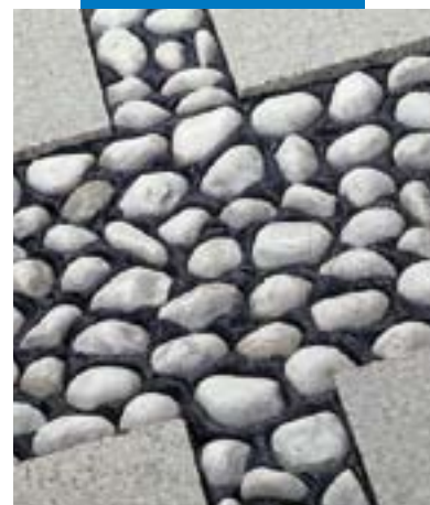
Voegwerk van decoratieve keien
