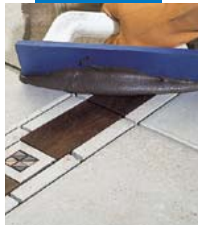
Gebruik van een voegrubber bij het voegen van een vloer van keramische tegels met houtinleg
