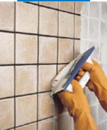
Gebruik van een voegrubber bij het voegen van enkelgebakken tegels
