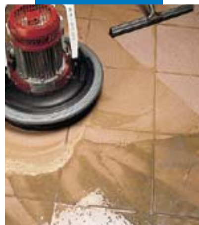
Gebruik van een rubber vloertrekker, inwas- en uitpoetsmachine bij het afwerken van een gresvloer
