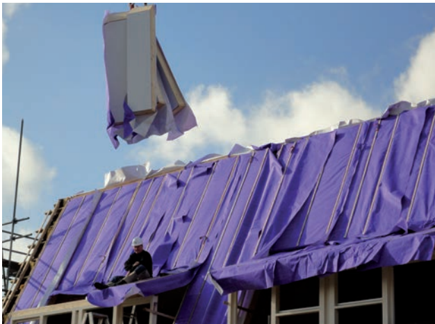
Met vlas geïsoleerde dakelementen....
