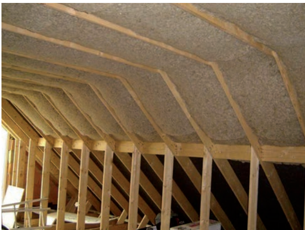
..en een met vlas geïsoleerde houtconstructie.
