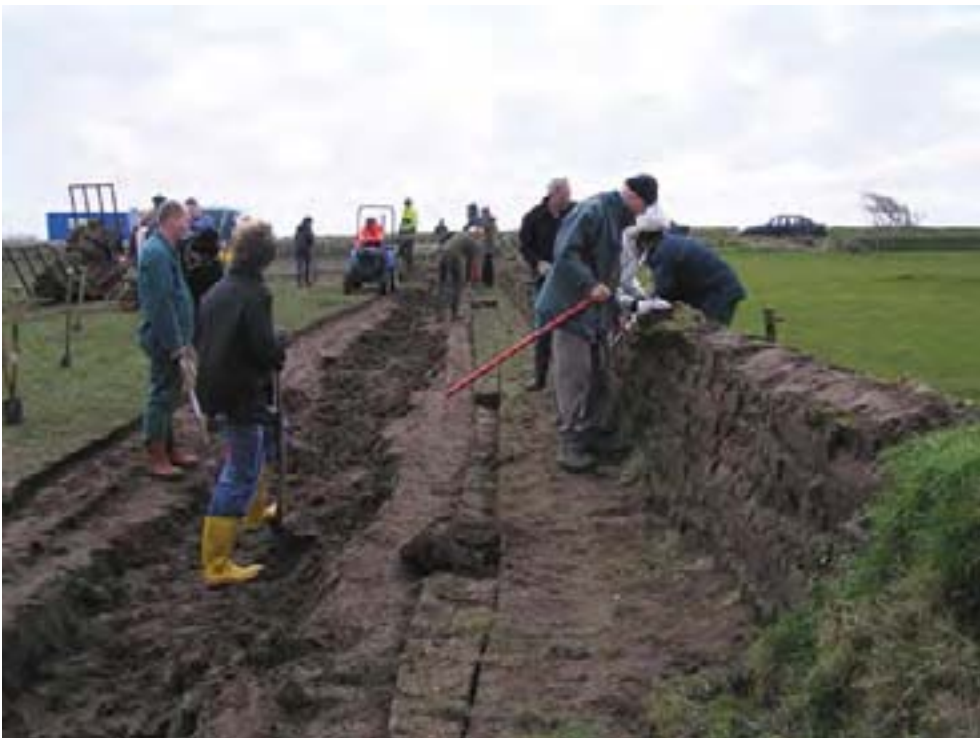
Afb. 10.7 Herstel van tuunwallen door Werkgroep Kwadijkse Vlot (foto Landschap Noord-Holland).
