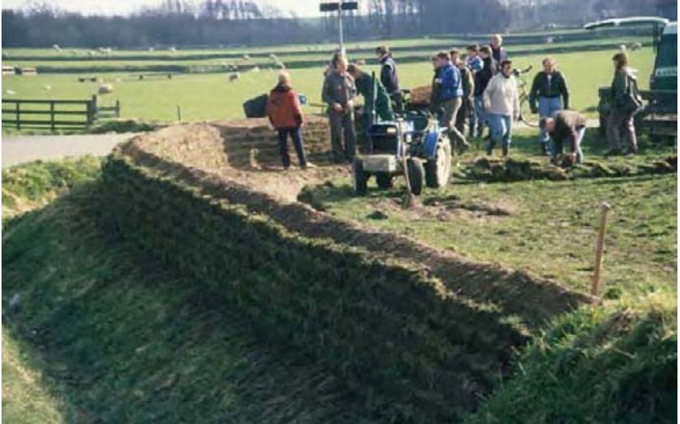
Afb. 10.3 Aanleg van nieuwe tuunwallen door de agrarische natuurvereniging De Lieuw (foto Landschap Noord-Holland).
