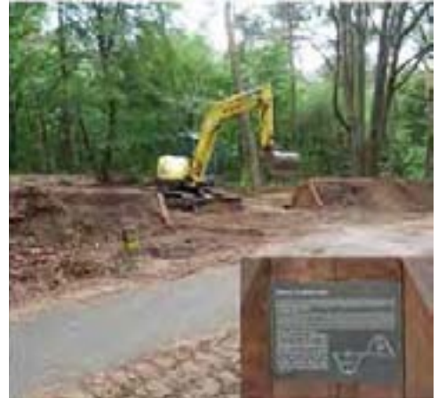
Afb. 13.12 Langs de Maldense baan bij Groesbeek is, waarschijnlijk in 1775, een wegwâl aangelegd om te voorkomen dat karren in modderige of mulle omstandigheden nieuwe paden gingen maken in het ernaast gelegen bos. Op een plek waar deze wal wordt doorsneden door een druk gebruikt wandelpad is het profiel van de betreffende wal aan beide zijden van het wandelpad geaccentueerd met behulp van houten damwanden. Op de damwand is een aluminium paneel bevestigd met uitleg over de wal (foto: Martijn Boosten).
