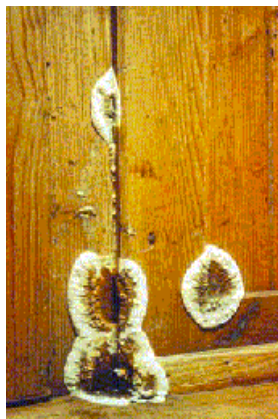
Afbeelding: vruchtlichaam van de huiszwam
