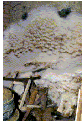
Afbeelding: vergevorderde aantasting door huiszwam.
