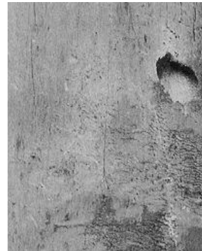
Afbeelding: uitvliegopeningen van de huisboktor.
