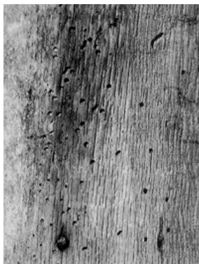
Afbeelding: oppervlak met uitvliegopeningen van de spinhoutkever.
