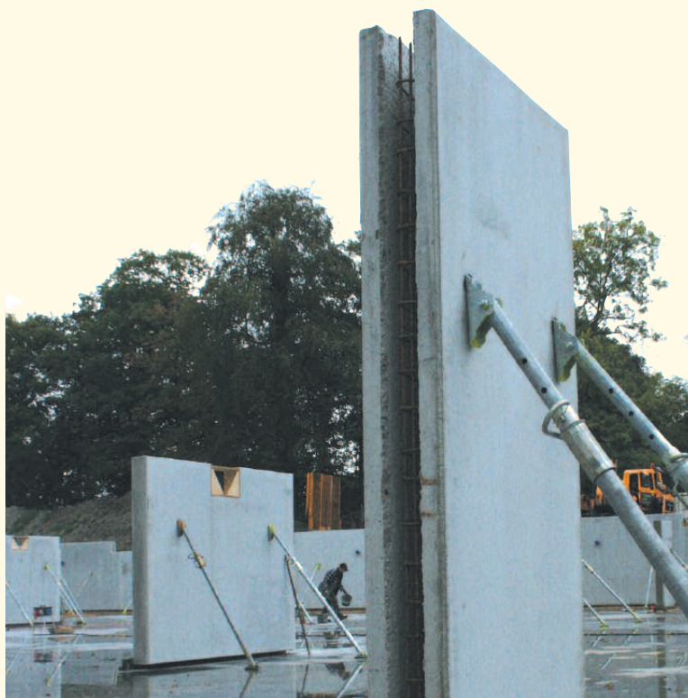
Detail trek-/drukschoren
