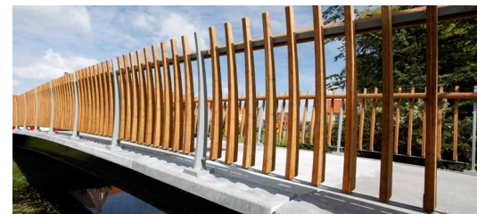
UHSB brug Volmolen Texel, 2016 afmetingen: l=17 m | b=2,5 m
