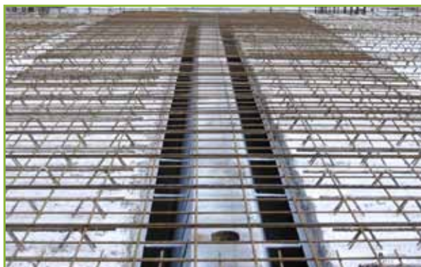
Foto: breedplaatvloer in combinatie met Deltabeam
