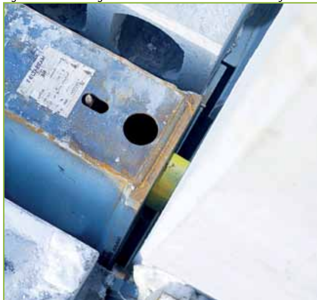
Figuur 9. Aansluiting Deltabeam met Peikko PCs-console systeem
