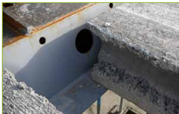
Foto: oplegging kanaalplaatvloer op onderflens Deltabeam
