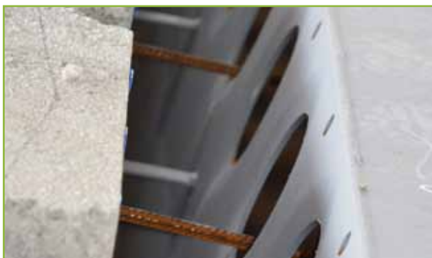
Figuur 7. Deltabeams kunnen worden toegepast als vrije oplegging, als doorgaande ligger of met overstek.
