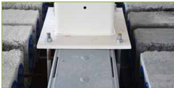
Foto: koppelwapening in opengehakte sleuven van de kanaalplaat
