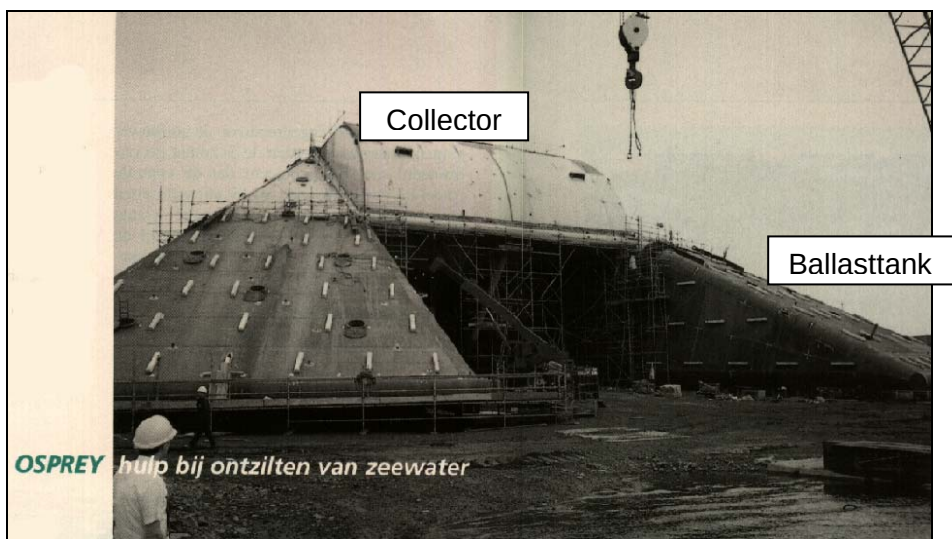
De Osprey tijdens constructie
