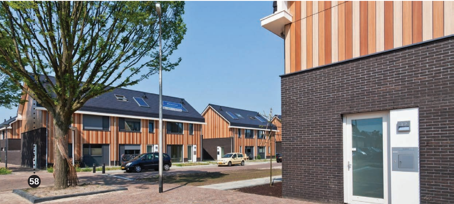
Afb. 9.3 211 houtskeletbouw-woningen, ‘duurzaamste woning van Nederland’, Velve Lindehof, Enschede Bron: Centrum Hout
