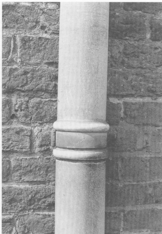
28. Zinken hemelwaterafvoer in STZ-14. Opgesoldeerde wrongen waardoor de beugel de pijp fixeert en uitzakken wordt voorkomen; eigenlijk de enig juiste wijze!
