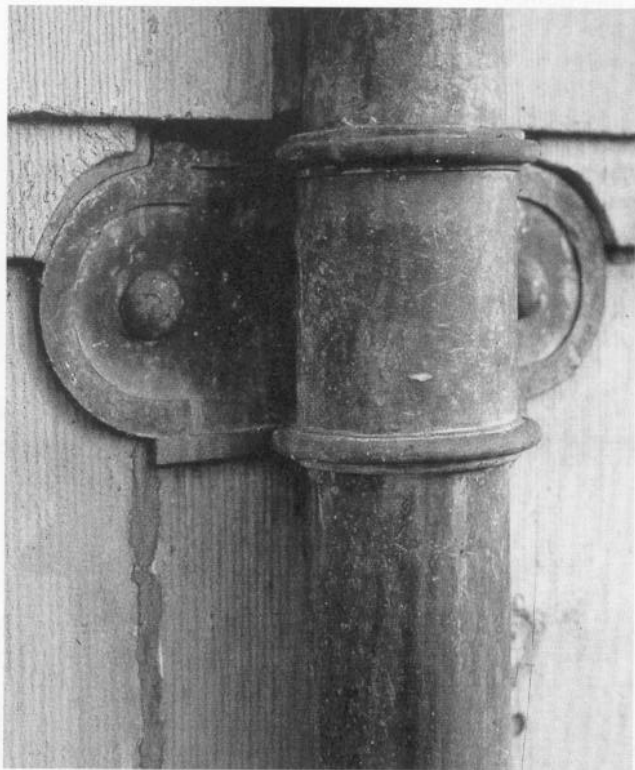
38. Een deugdelijk opgehangen loden afvoer met een zeer zware manchet met versterkte rand.
