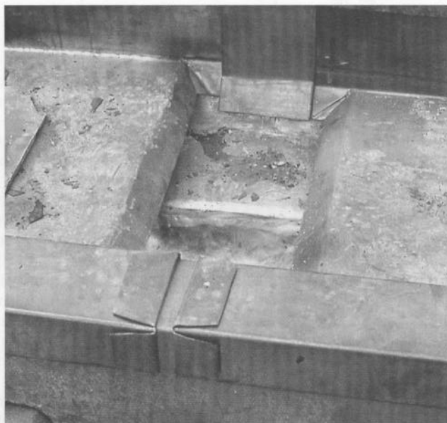
32. Bij brede goten kan een expansiemogelijkheid worden gemaakt door beide gootdelen te laten eindigen in een over de volle diepte van de goot doorlopende vergaarbak
