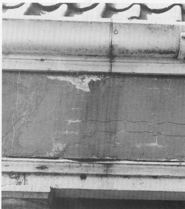
43. Een lekkende naad in een gietijzeren goot met moffen. De gevolgen voor het onderliggende pleisterwerk zijn duidelijk te zien.
