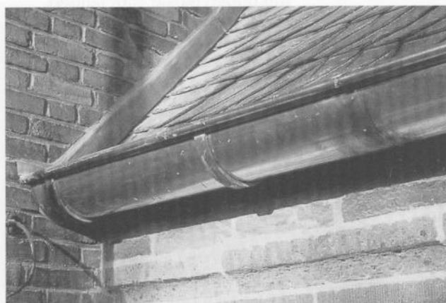
5. Een goed geconstrueerde mastgoot met zware koperen beugels 8 × 40 mm.
