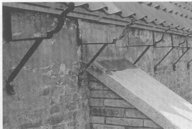
6. Aangepaste beugels voor een vrijdragende bakgoot met ondersteunende plank.
