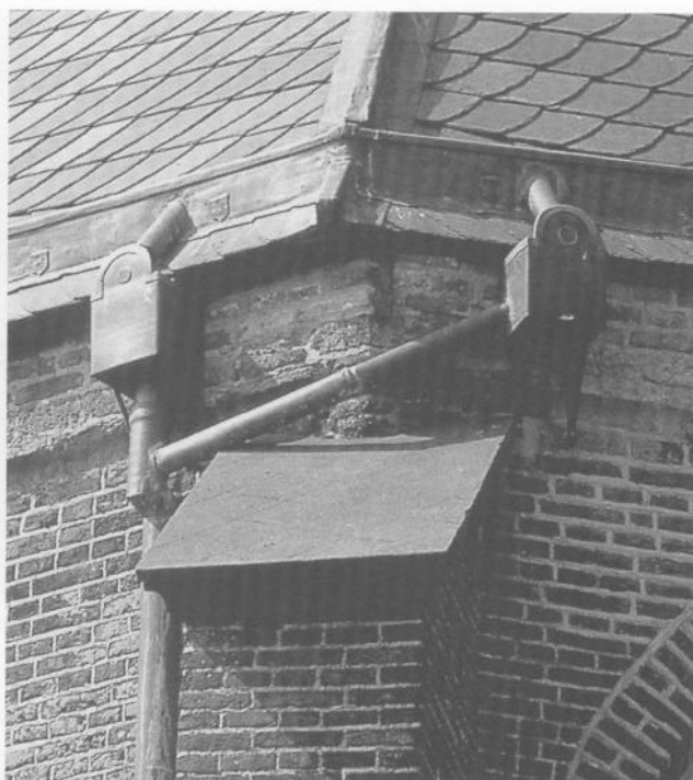
23. Instructief voorbeeld van zeer moeilijk schoon te maken vergaarbakken, met een ingewikkelde aansluiting van de hemelwaterafvoeren. Deze constructie staat garant voor verstoppingen.
