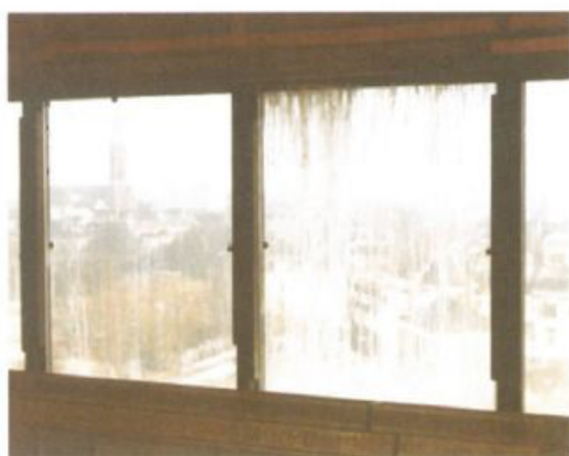
Figuur 3 Glasschade als gevolg van lekwater uit beton.
