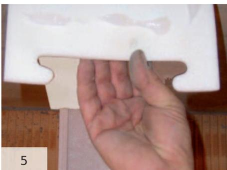
**Wichtig:** Beim Verputzen ist darauf zu achten, dass die Profile nicht überputzt werden. Die Sichtbarkeit der Profilkante dient als Indikator für die korrekte Ausführung.
