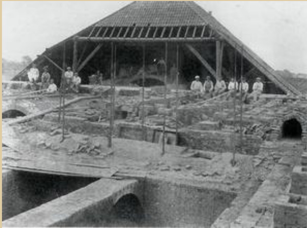
Ovengebouw en zigzagoven in aanbouw.
