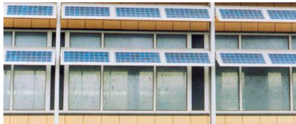
Een mooie manier om zonnecellen toe te passen is geïntegreerd in buitenzonwering.
