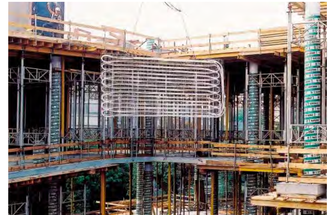
Betonkernactivering is een manier om via de constructie te koelen. Hier wordt het leidingennet geplaatst.
