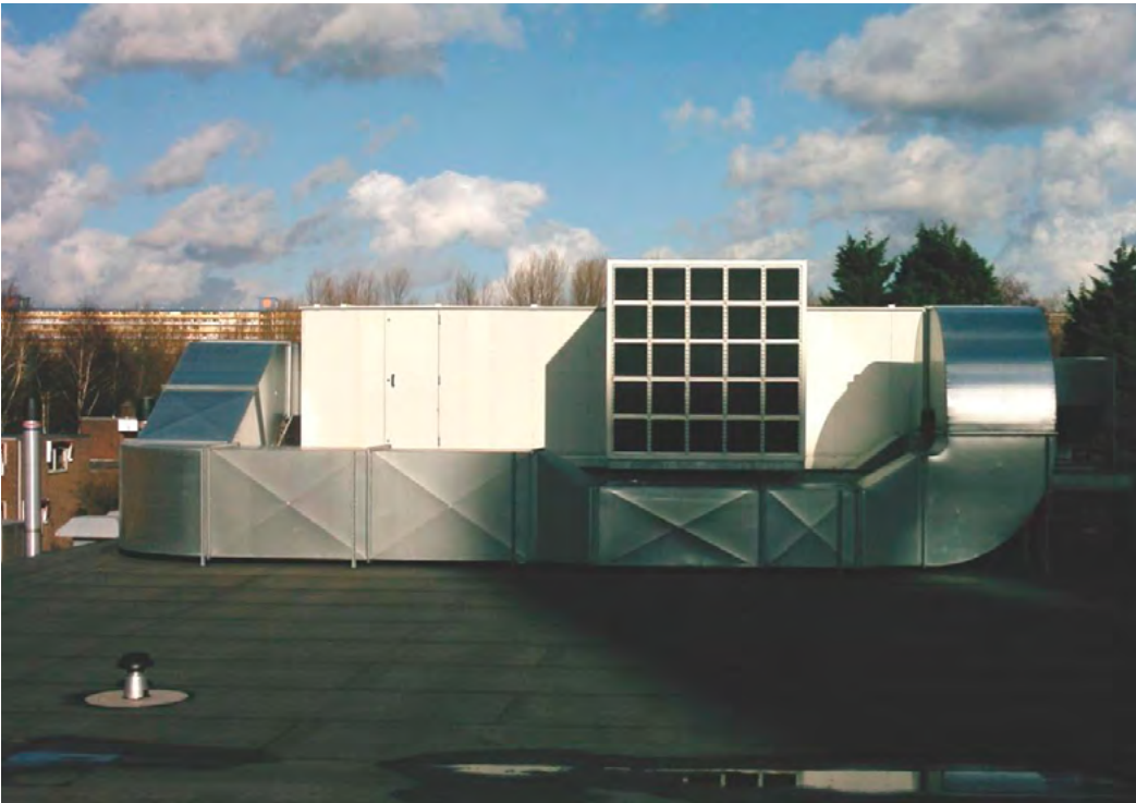
In de luchtbehandelingskast op het dak vindt warmteterugwinning uit ventilatielucht plaats met behulp van een kantelklep-systeem.
