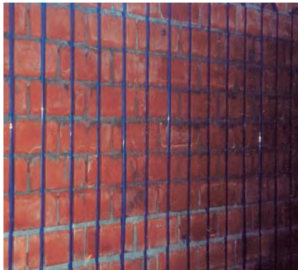
Deze wand wordt voorzien van wandverwarming.
