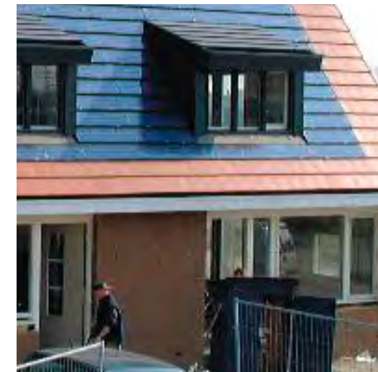
PV-cellen als film over een strook dakpannen.
