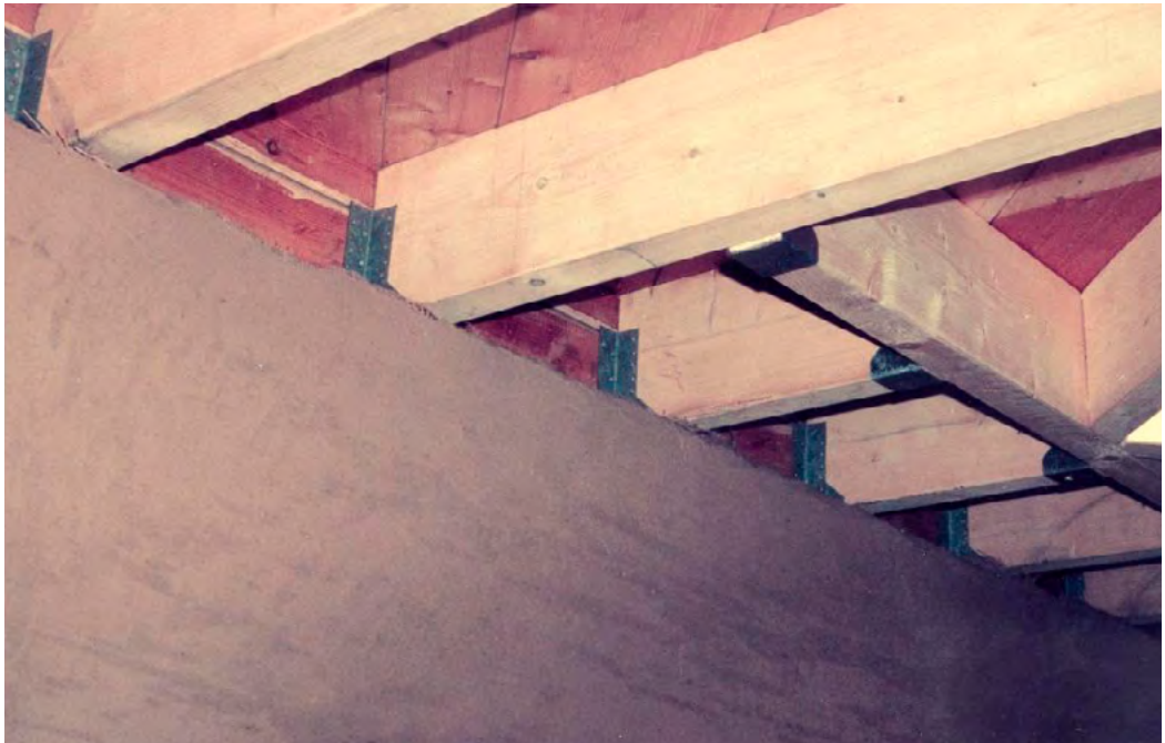
Een dikke laag leemstuc geeft de houten woning massa.
