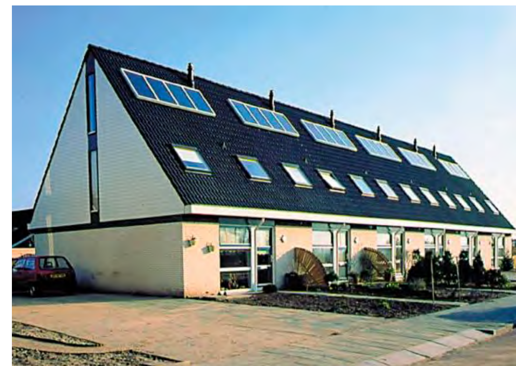
Vlakke plaat collectoren geïntegreerd in het dakvlak.
