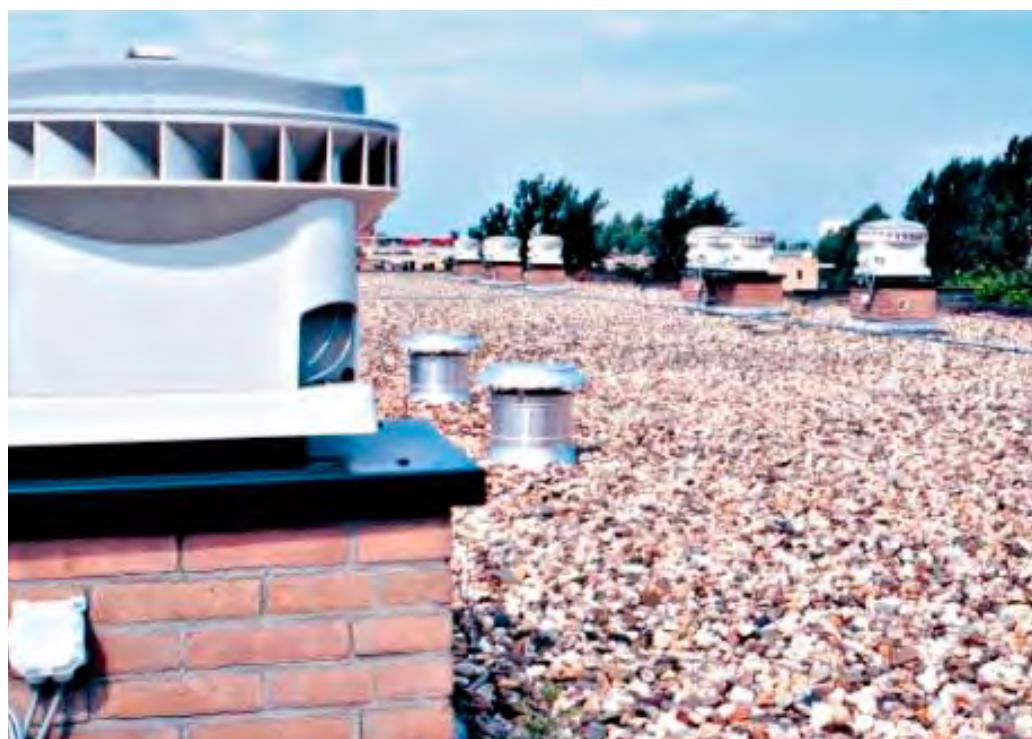
Bij mechanische ventilatie kan warmteterugwinning plaats vinden met behulp van een warmteterugwin-unit op het dak.
