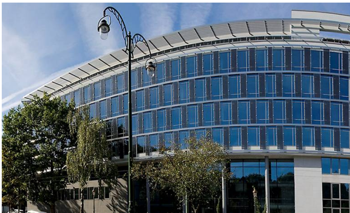
Het Solaris gebouw in Brussel (2009) met drievoudig glas in een Sapa aluminium gevel, zonneschermen en bouwkundig geïntegreerde zonnecellen. Architect: Assar Architects BVBA
