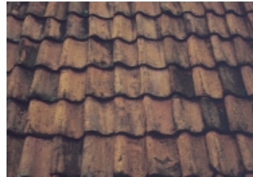
Opmerkelijke textuurverschillen tussen Hollandse en Verbeterde Hollandse pannen (foto's M. Polman)
