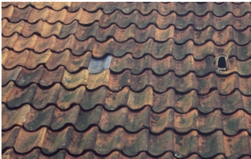
Hollands pannendak voorzien van een kappan en een glazen pan (foto M. Polman)
