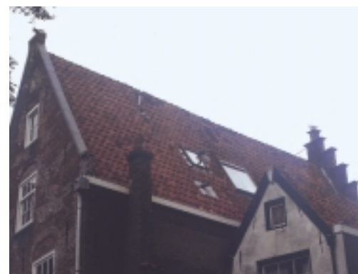
Dakramen en afvoerpijpen doorbreken de geslotenheid van het historische pannendak
