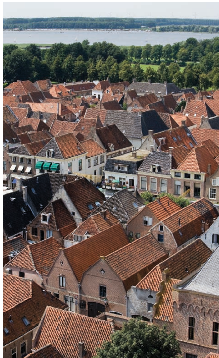
Elburg vanaf de kerktoeren: het effect van een consequent terughoudend gemeentelijk beleid ten aanzien van dakkapellen en dakramen. In veel steden en dorpen is het daklandschap nogal eens een vergeten dimensie van ruimtelijke beleving
