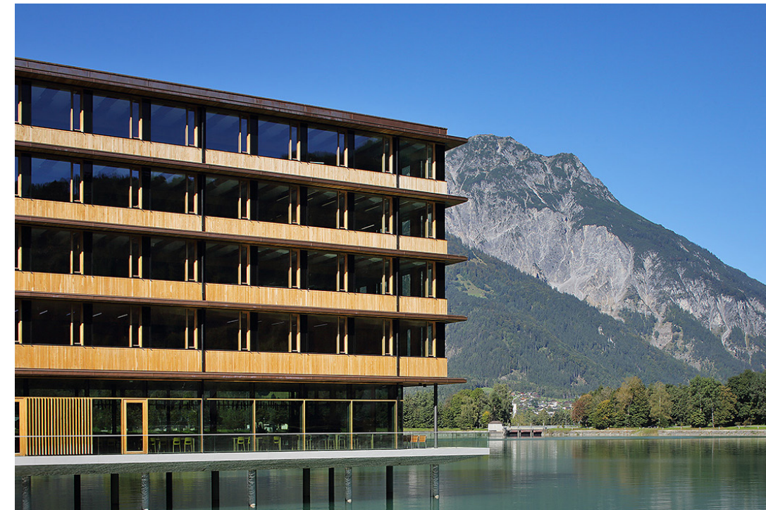
Illwerke Zentrum Montafon - Hermann Kaufmann Architekten (Fotograaf: Norman Radon)
