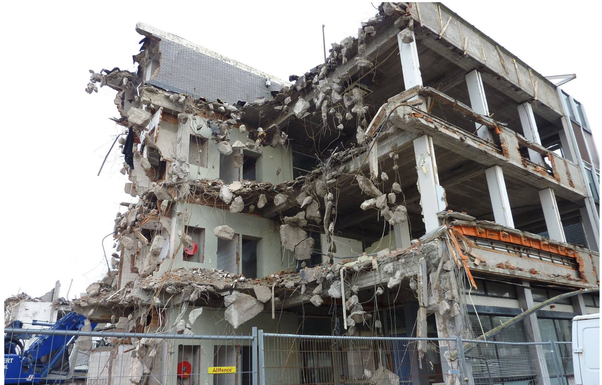
De sloop van een betongebouw kost veel geld en energie en levert weinig herbruikbare bouwmaterialen op.
