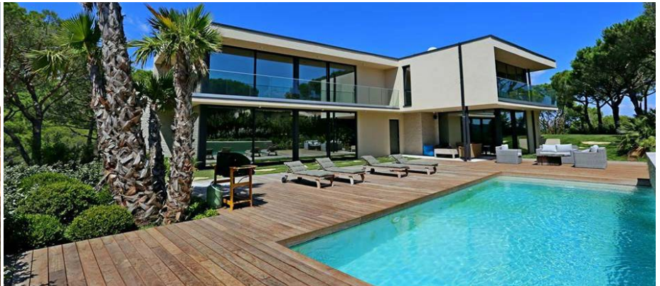
▲ Villa TimberTeam in Ramatuelle, voor en na, met pleisterlaag
