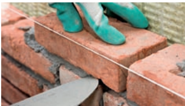
Na het invlijen de steen niet aankloppen
