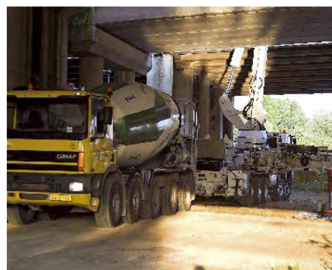
• Inzet van een stationaire betonpomp bij het hoogste woongebouw in Nederland: de Montevideotoren in Rotterdam.
