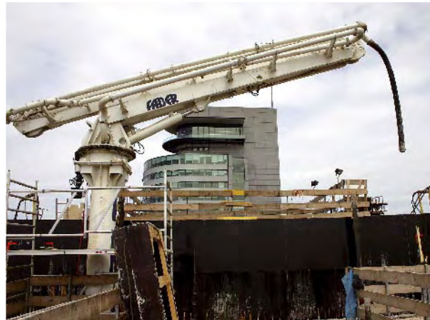
• Inzet van een stationaire betonpomp bij het hoogste woongebouw in Nederland: de Montevideotoren in Rotterdam.
