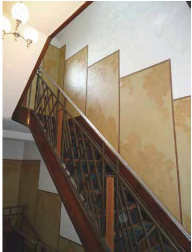
Traphal na interventie. (Foto : C. Fontaine) Cage d'escalier après intervention.
