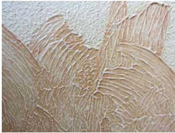
Pendant la réalisation : Embus après le premier passage, détail de la sortie des reliefs et passage du glacis final. (Photos : C. Fontaine) Tijdens de uitvoering : Ingeschoten matte zones na de eerste glacis, detail van afgeveegde reliefs en aanbrengen van derde glacislaag.
