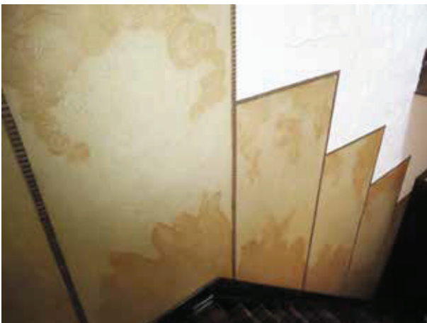
Cage d'escalier après intervention. (Photo: C. Fontaine) Traphal na interventie.
