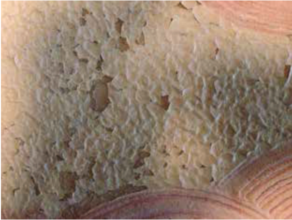
Écaillage du surpeint avec perte de matière. (Photo M. Sonck) Afschilfering van de overschildering met materiaalverlies.
