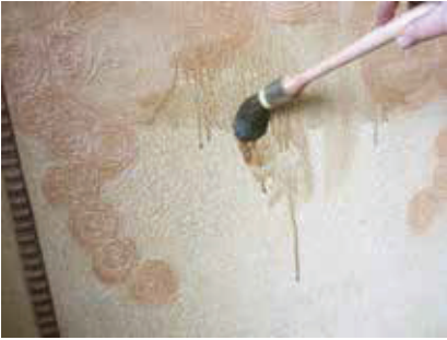
Pendant la réalisation : Embus après le premier passage, détail de la sortie des reliefs et passage du glacis final. (Photos : C. Fontaine) Tijdens de uitvoering : Ingeschoten matte zones na de eerste glacis, detail van afgeveegde reliefs en aanbrengen van derde glacislaag.
