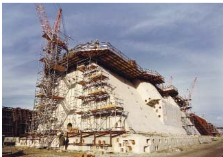
Massabeton: pijlers in aanbouw voor de stormvloedkering in de Oosterschelde
