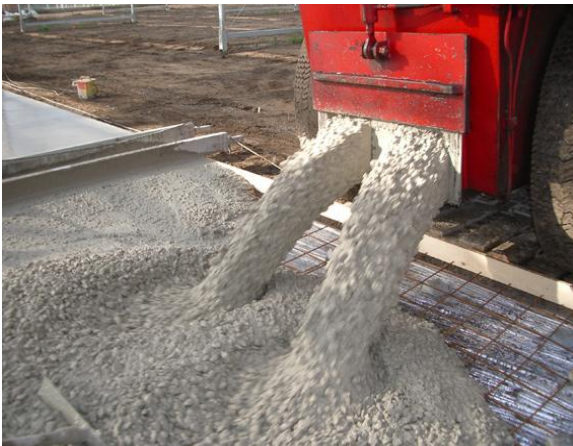
Figuur 3: Beton wordt gestort over de voorgespannen wapening.
