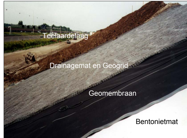
Afbeelding 4. Opbouw van afdichtingsconstructie
