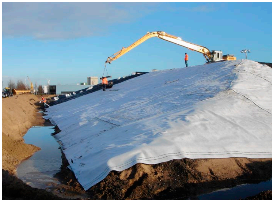
Aanbrengen van folie voor het afdekken van de avi-bodem-as.
