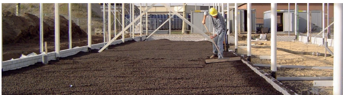
Industriebouw dubbele wapening
