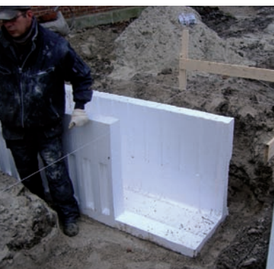
Uitgraven bouwput en plaatsen PS bekistingselementen
