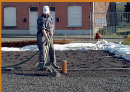
Stabiliseren met cementmelk
