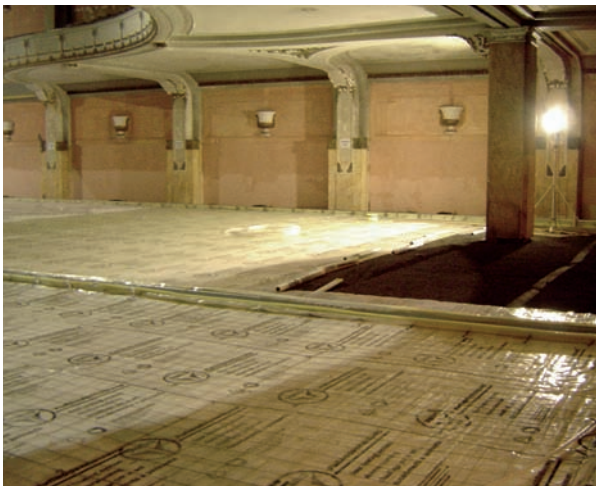
Vloerverwarming, renovatie Roma, Borgerhout
