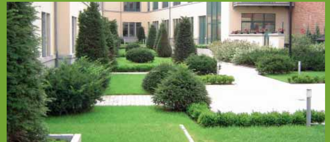
Tongeren, Gerechtsgebouw: Intensieve daktuin
