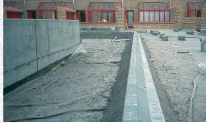
Brugge, Karthuyzerwijk: Boordstenen in draineerbeton
