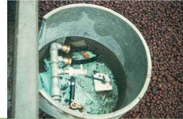
Permanent waterniveau met vlotter
