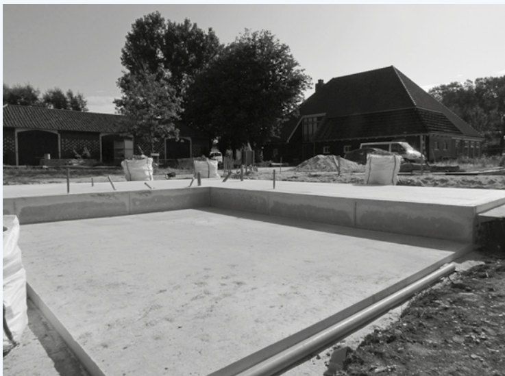
Testopstelling van Trilling Absorberend Schuimbeton (TAS).
