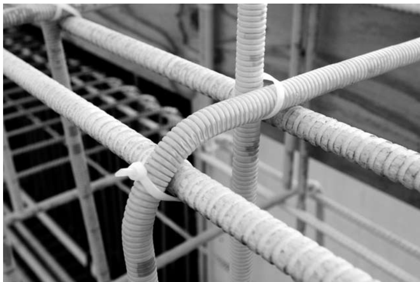
Staven gekoppeld met kunststof tie-rips
