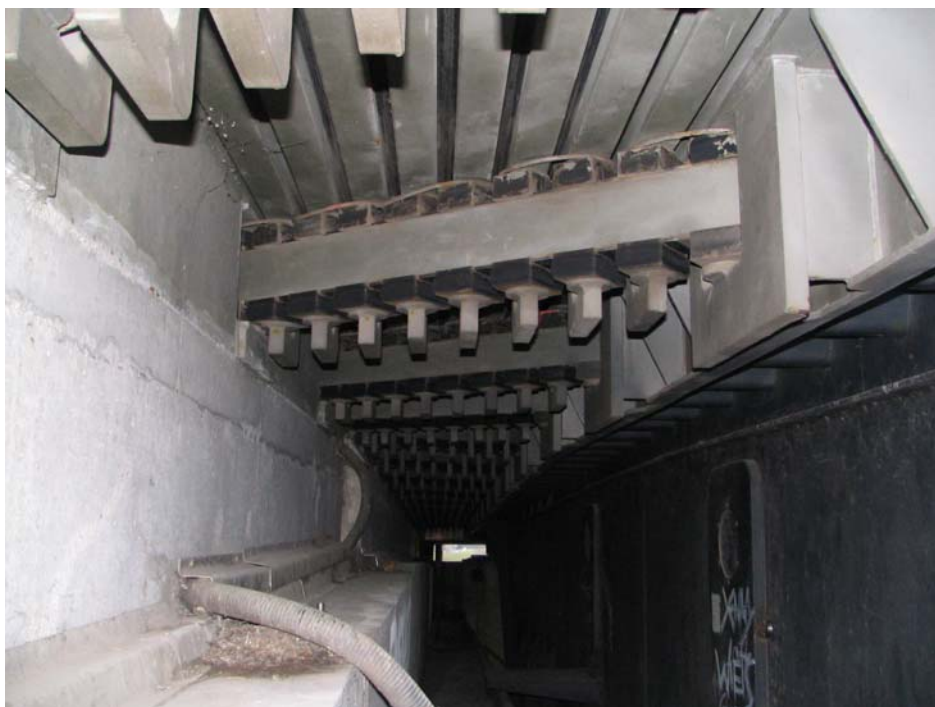
Figuur 8.9 Onderzijde Schwenktraversenvoeg Maurer type DS 720
