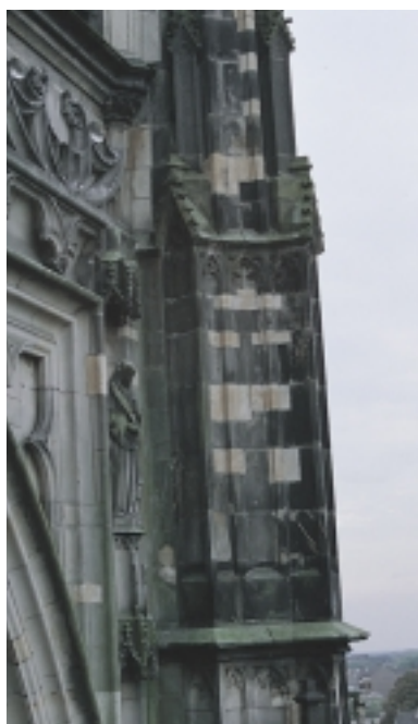
Kalksteenblokken te midden van zandsteen. De kalksteen wordt steeds lichter, de zandsteen steeds donkerder van kleur. Onder invloed van het zandsteenbesluit, waarin is vastgelegd dat het gebruik van zandsteen niet meer is toegestaan, is in de jaren vijftig van de twintigste eeuw in plaats van zandsteen kalksteen toegepast
