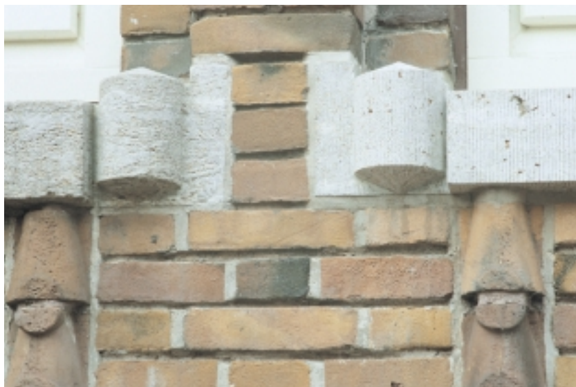
De ideale situatie: Musschelkalksteen (links) vervangen door hetzelfde materiaal (rechts)
