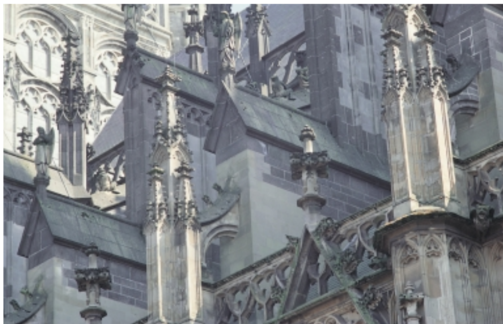
Vanaf de jaren zestig van de twintigste eeuw werd in plaats van kalksteen basaltlava als vervanger van zandsteen gebruikt, met wisselend succes. De foto boven laat zien hoe donkere Duitse basaltlava afsteekt tegen de lichtgrijs verweerde omgeving. Op de foto links is te zien hoe Franse basaltlava wat kleur betreft goed aansluit bij de grijs verweerde zandsteen
