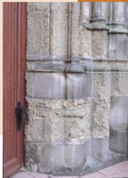
Zandsteen vervangen door tufsteen. De tufsteen is inmiddels weer aan vervanging toe, terwijl de oorspronkelijke stukken zandsteen nog gaaf zijn
