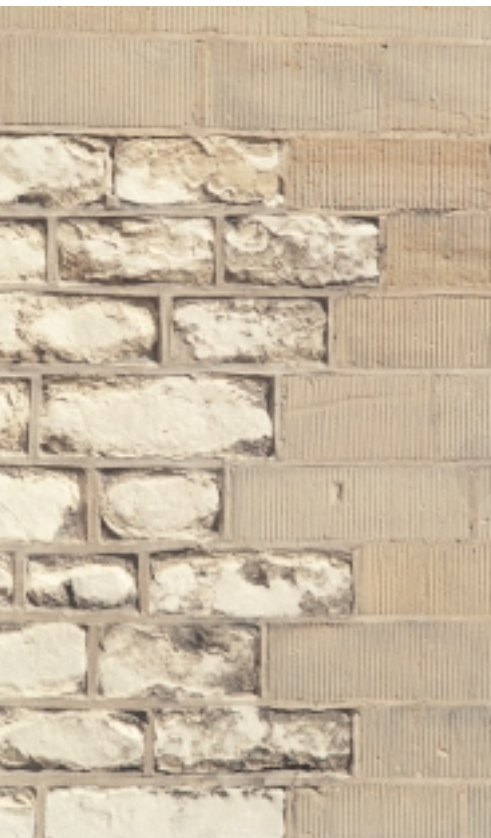
Gobertanger (links) eind negentiende eeuw vervangen door Udelfanger zandsteen (rechts). Gesteentes die ieder hun eigen specifieke en vooral van elkaar verschillende verweringsvorm kennen
