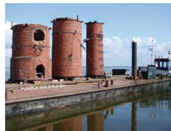
Deze gedemonteerde fabrieksschoorsteen, in Sneek gebouwd in 1929, wordt herplaatst bij het Gemaal van Echten
