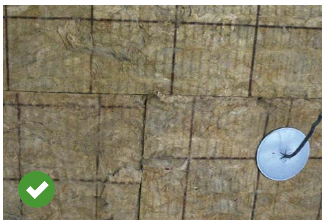
Isolatie correct strak en sluitend aangebracht.
