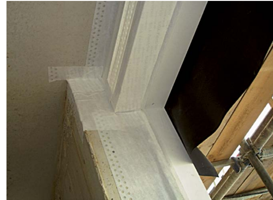
Kozijn aan de binnenzijde luchtdicht afgeplakt.
