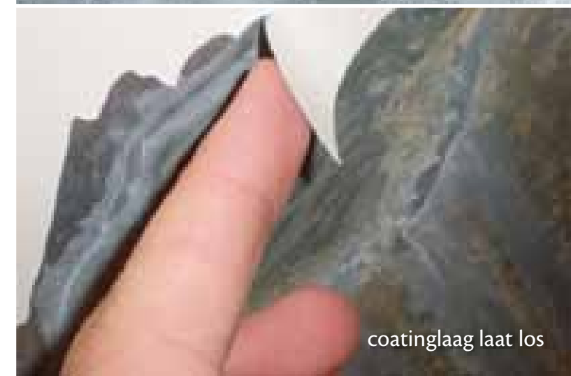
beschadigde tegelwand
